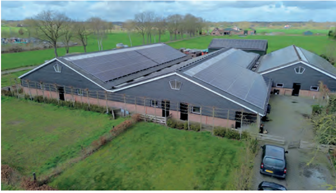
⤴ Een derde stal is tussen twee stallen geplaatst, alle stallen zijn nu aan elkaar verbonden.
